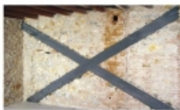
Fig. 2 rinforzi per azioni nel piano (taglio)
